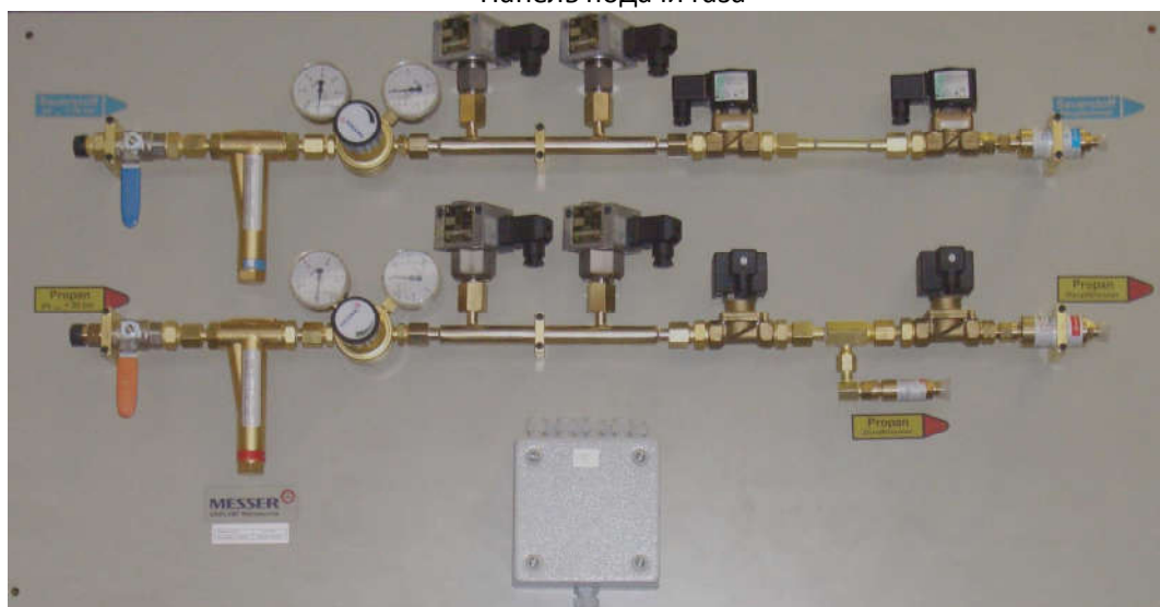
Панель подачи газа
